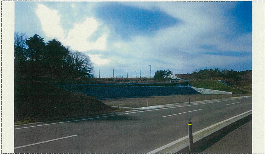
平成 28 年 1 月 27 日 測点 北東面 工事概要 着工前
