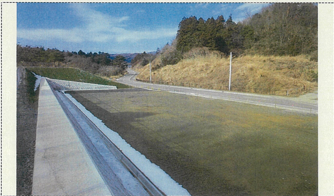
平成 28 年 1 月 27 日 測点 南東面 工事概要 着工前
