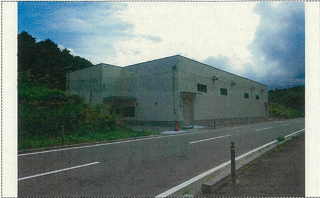
平成 28 年 8 月 31 日 測点 北東面 工事概要 竣 工
