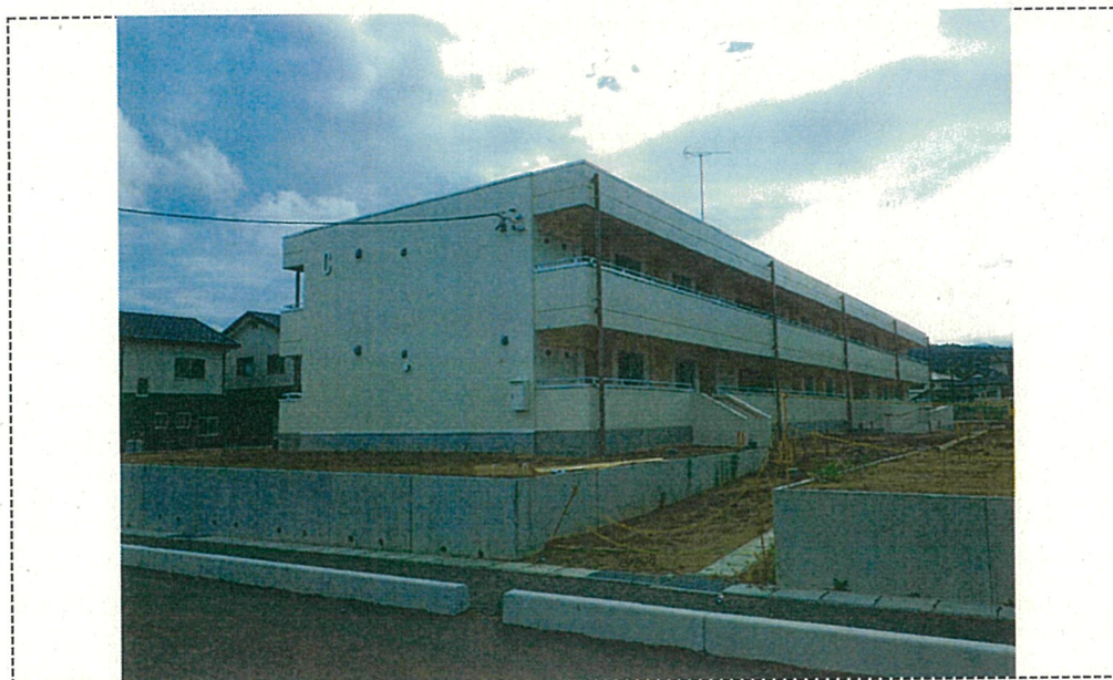
平成 26 年 9 月 26 日 測点 敷地東面 工事概要 C 棟 全 景
