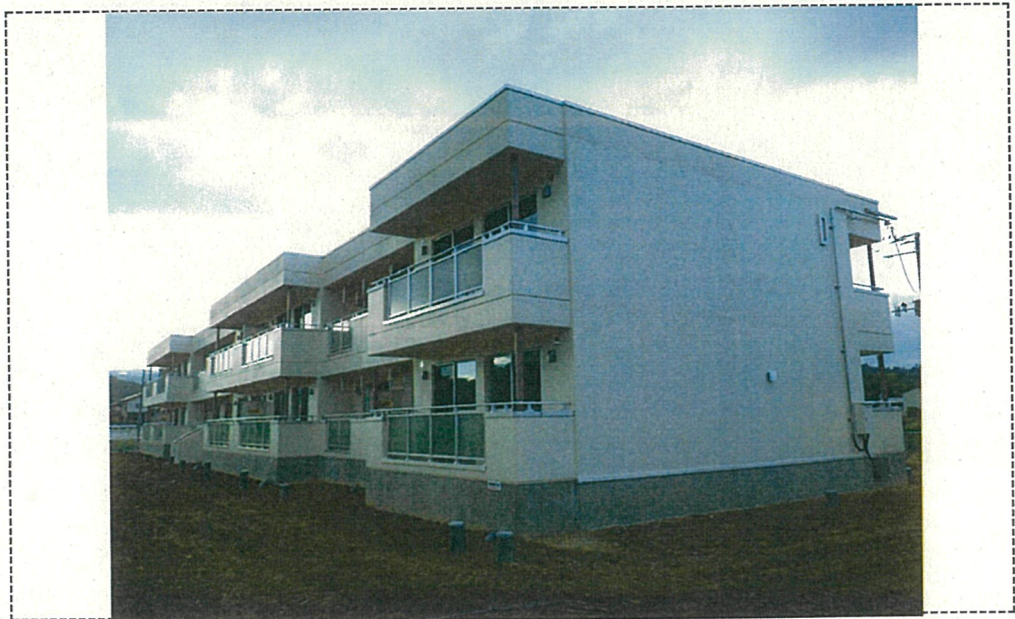
平成 26 年 9 月 26 日 測点 敷地北面 工事概要 D 棟 全 景
