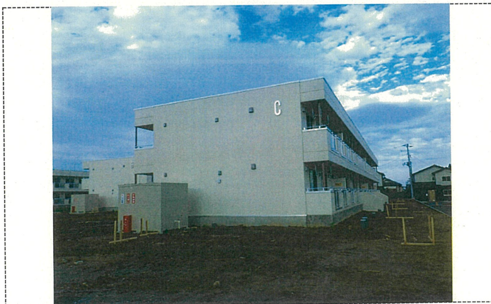
平成 26 年 9 月 26 日 測点 敷地北面 工事概要 C 棟 全 景
