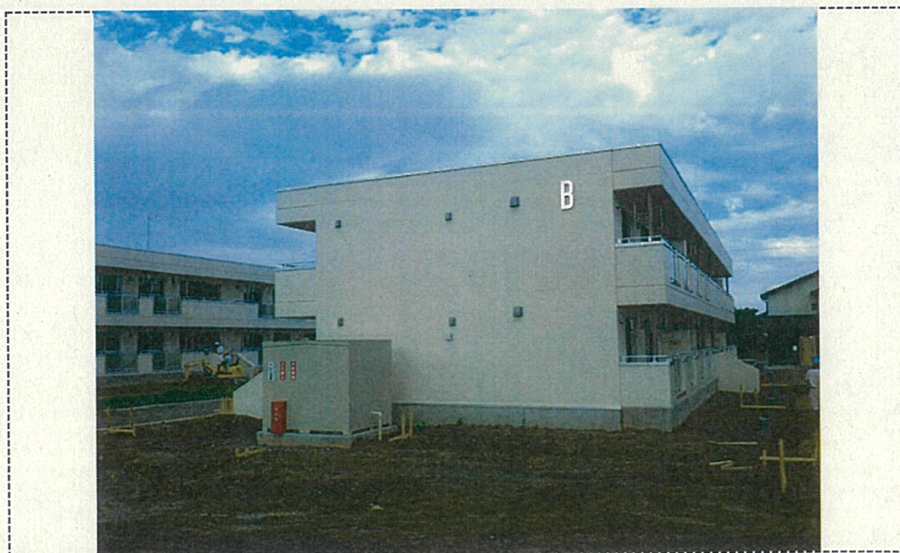
平成 26 年 9 月 26 日 測点 敷地南東面 工事概要 B 棟 全 景
