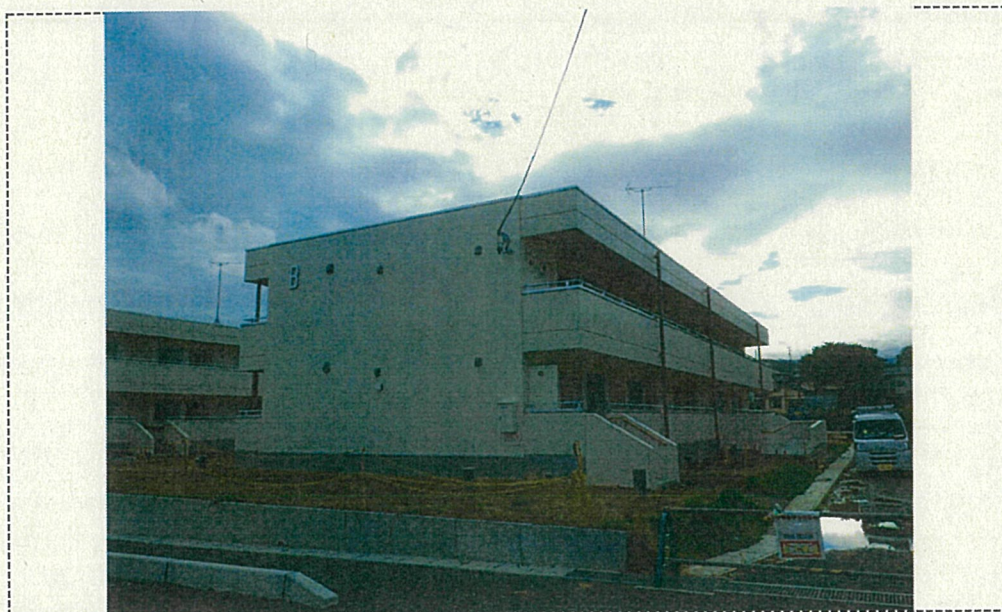
平成 26 年 9 月 26 日 測点 敷地西面 工事概要 B 棟 全 景
