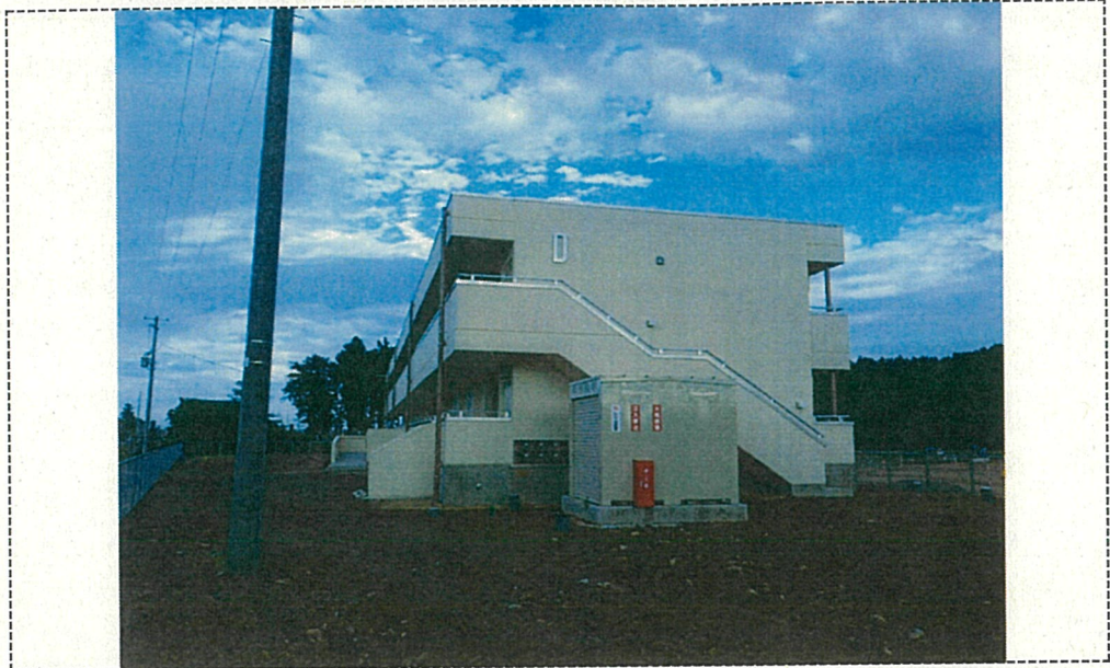
平成 26 年 9 月 26 日 測点 敷地東面 工事概要 D 棟 全 景
