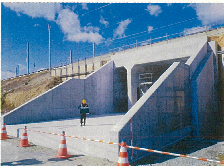
U型擁壁新設工
