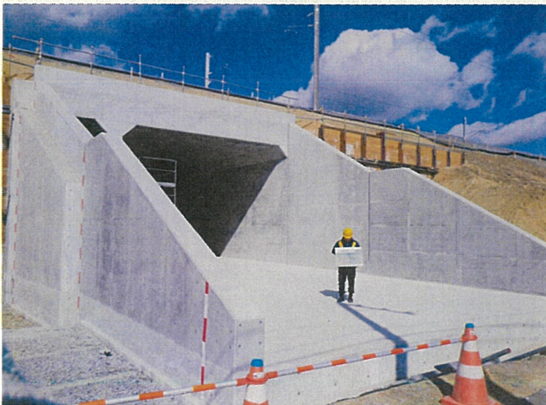
U型擁壁新設工
