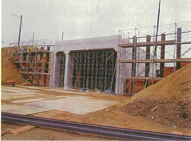
U型擁壁新設工
