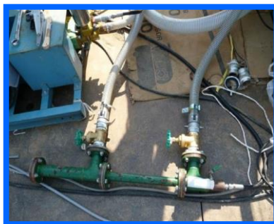
②剥離洗浄
