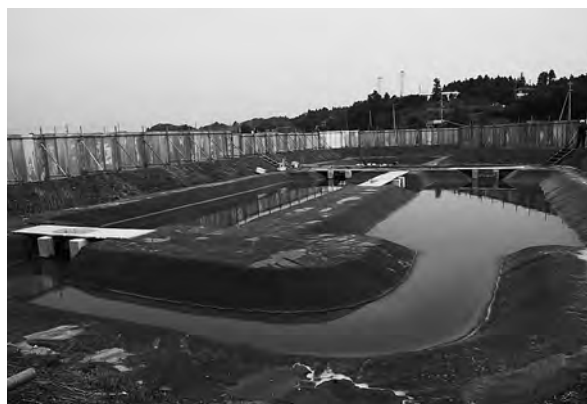
▲工事が完成した仮設の下水処理場
