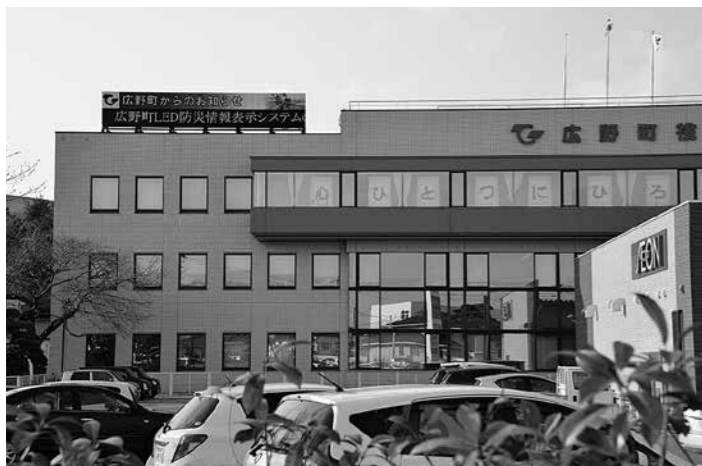
役場庁舎屋上に設置された「LED防災情報表示システム」
