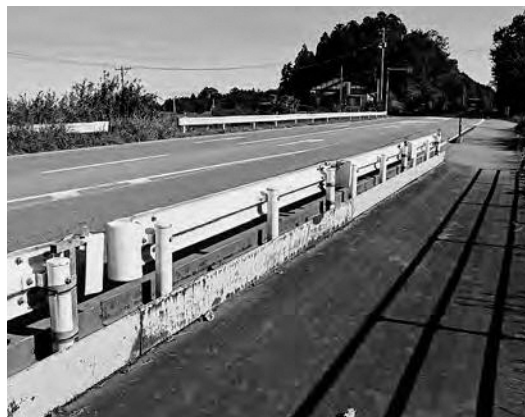
現在の仮設ガードレール設置状況
