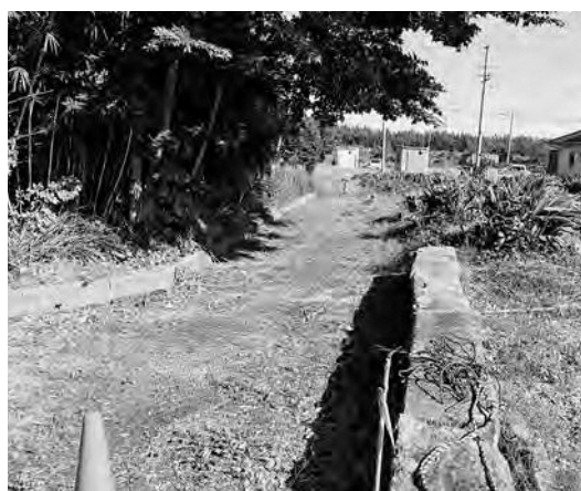
赤道整備予定箇所の様子
