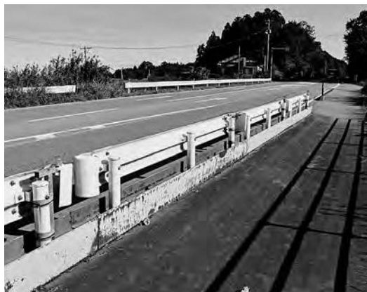
現在の仮設ガードレール設置状況
