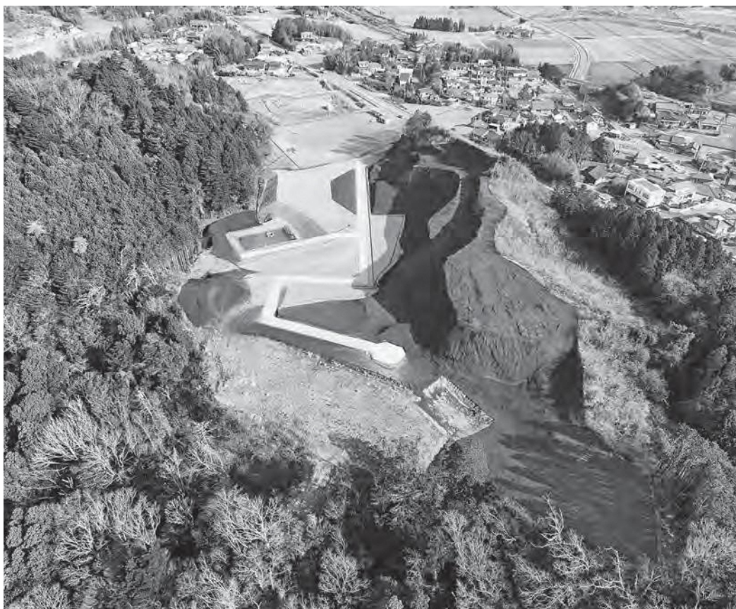
折木地区土砂採取区域 現場写真
