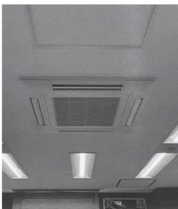
空調設備 施工後
