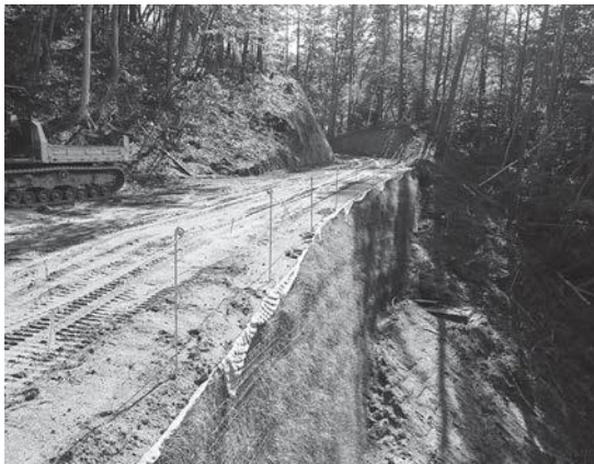
林専道（7工区）の様子 （補強土壁工）
