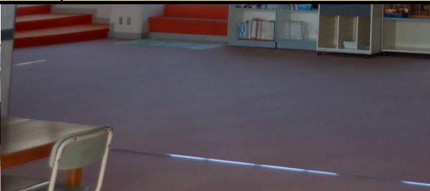
カーペット床の撤去とフローリング化
