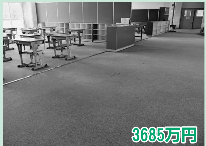
広野小学校南校舎のカーペット状況と間仕切り設置予定箇所
