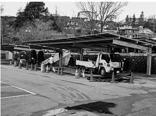
広野町役場北側駐車場 ソーラーカーポートの様子
