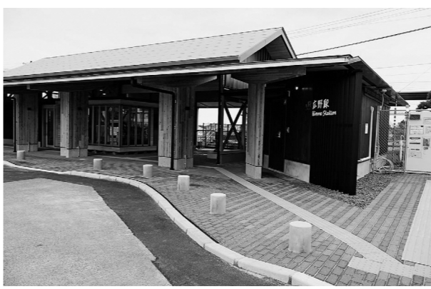
新広野駅舎の様子
