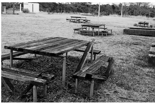
バーベキュー広場にある腐食している机や椅子の様子
