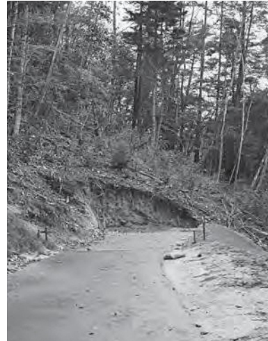
狼山叶沢線工事箇所
