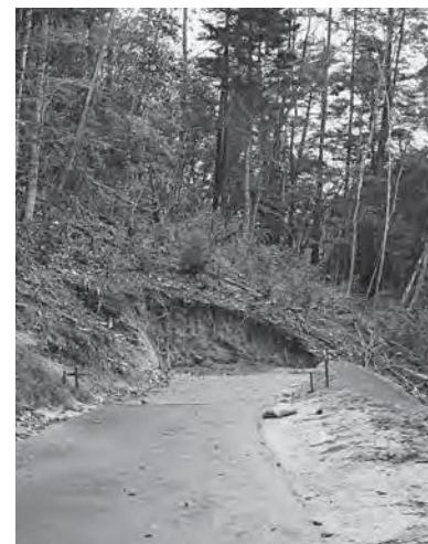
狼山叶沢線工事箇所
