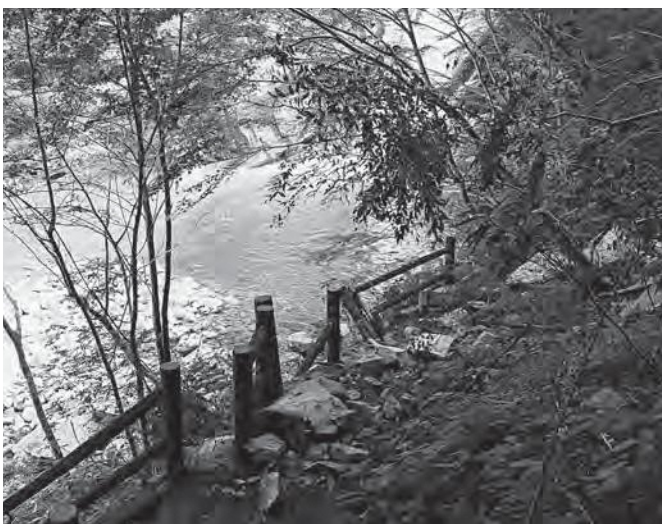
落石のある大滝遊歩道
