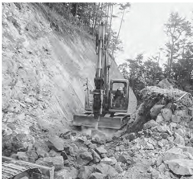
出現した岩盤（6工区）
