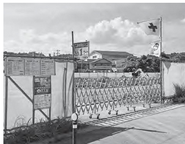
建設が始まった二光製作所 （駅東側産業団地）
