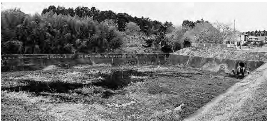
雑木等を除去した広洋台調整池
