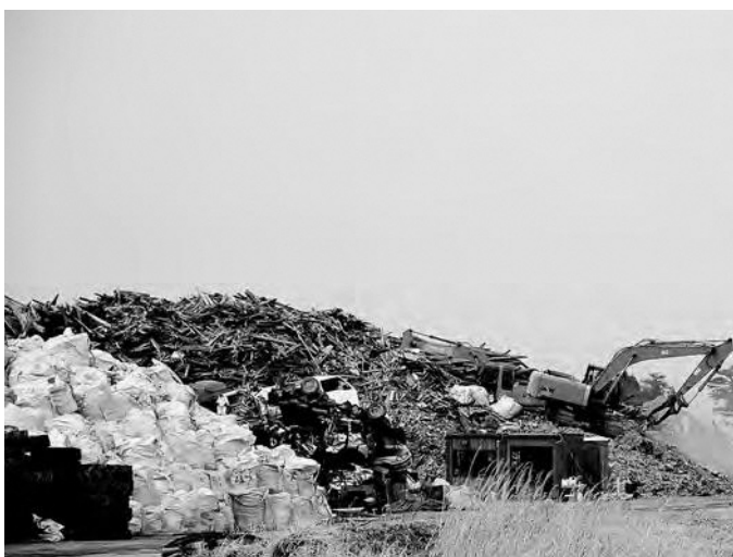
東日本大震災時の災害がれき仮置場 (現東町産業団地)
