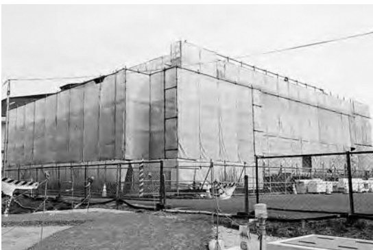
鉄骨柱の組立が進む 新給食センター
