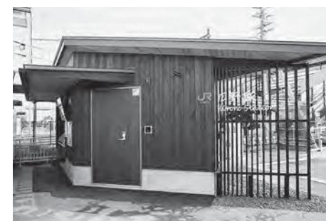
供用が開始された新駅舎
