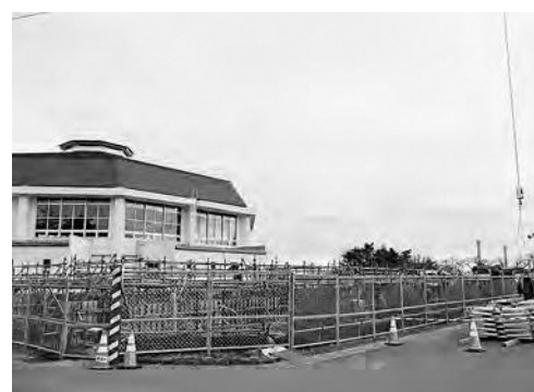
基礎工事が進む新給食センター
