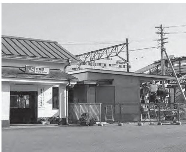
工事が進む新広野駅舎（コンパクト駅舎）
