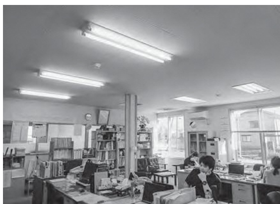
LED化されていない老人福祉センター
