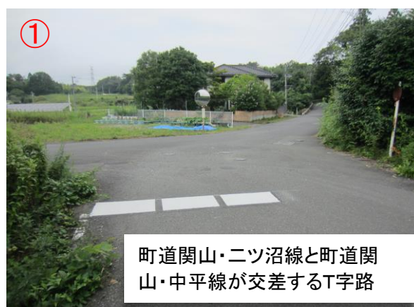
【指導停止線（破線）】標識なし
