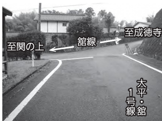
見通しが悪い折木字館地区交差点 (大平方面より)
