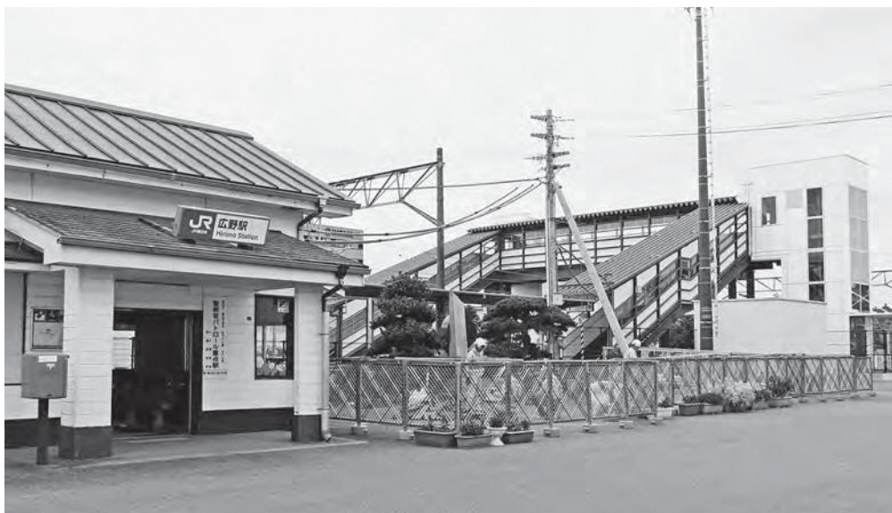
着工した新広野駅舎（コンパクト駅舎）建設工事
