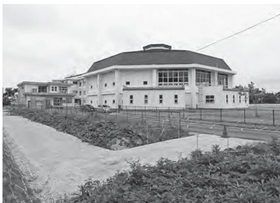
完成した仮歩道
