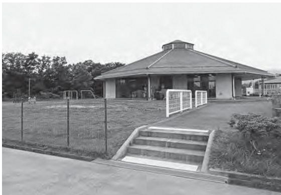
フェンスで囲われていない館庭北側
