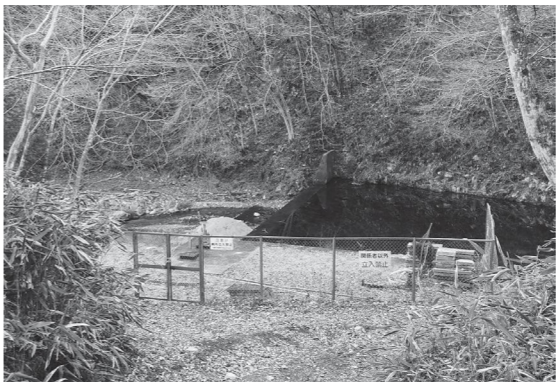
浅見川の上水道大船水源地
