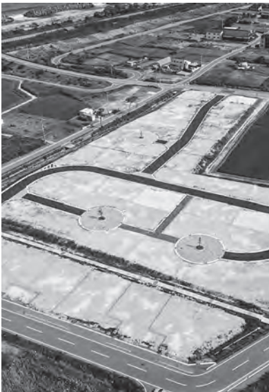
完成した駅東側住宅団地造成地
