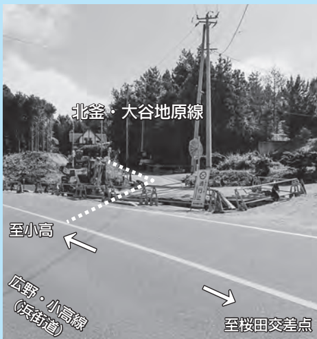
工事が始まった北釜・大谷地原線起点
