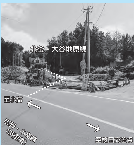
工事が始まった北釜・大谷地原線起点
