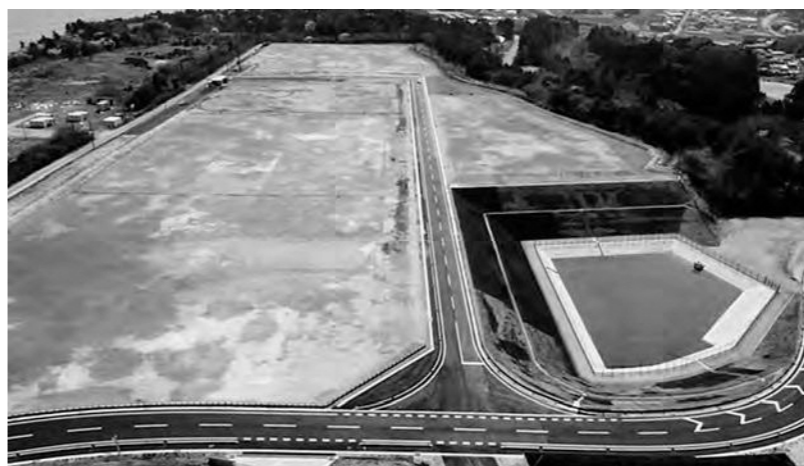
完成した東町産業団地
