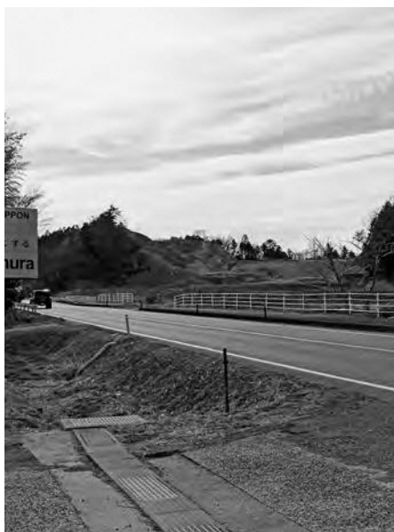
道の駅整備工事が凍結した工事現場
