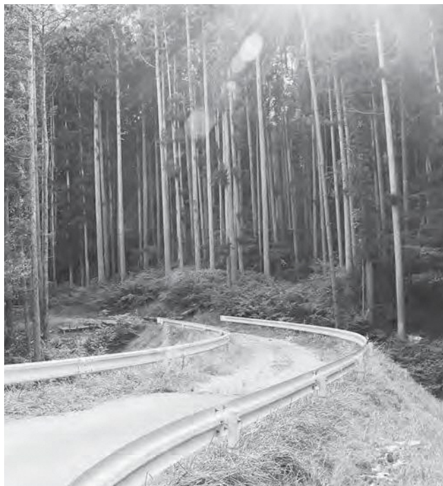
林業専用道「柴橋・東黒森線」を整備
