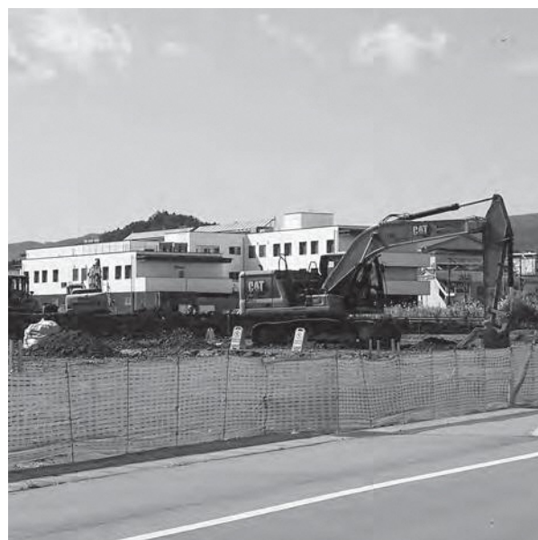
宅地造成工事
