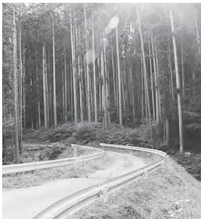
林業専用道「柴橋・東黒森線」を整備
