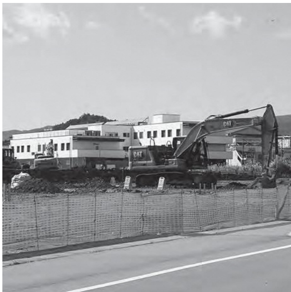
宅地造成工事
