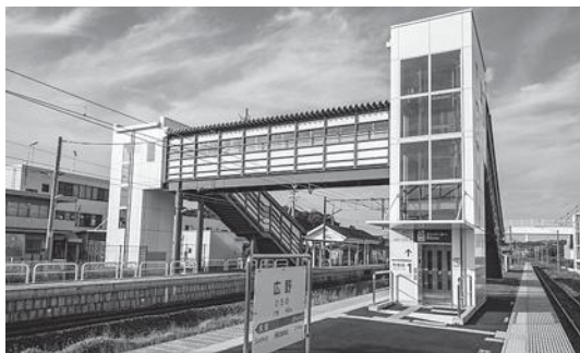
広野駅構内エレベーター
