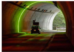
車載カメラによる点検
