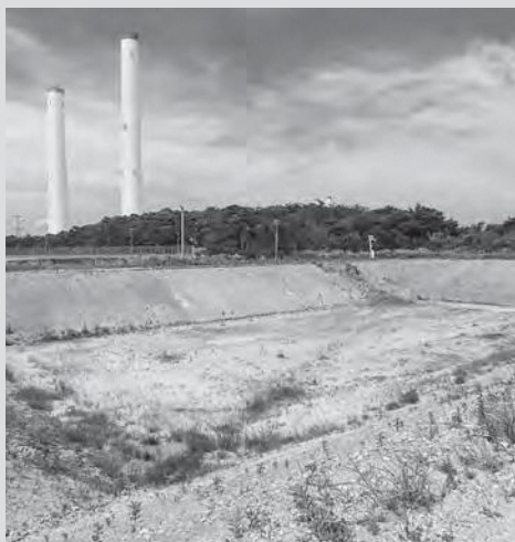
原型復旧工事が変更された東町仮置場
