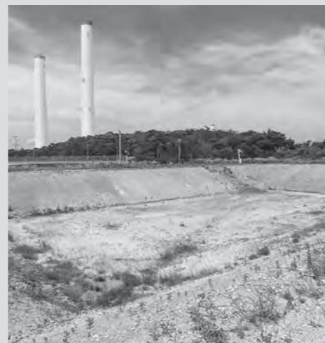
原型復旧工事に変更された東町仮置場
