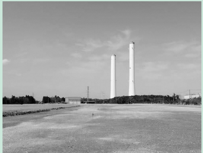
仮置場の原型復旧工事を実施中
