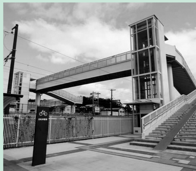
エレベーターが設置された未来のかけ橋
