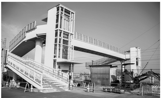
「未来のかけ橋」へのエレベーター設置工事
