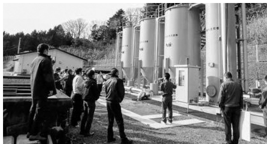
小滝平浄水場
