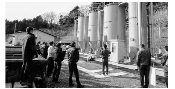
小滝平浄水場
