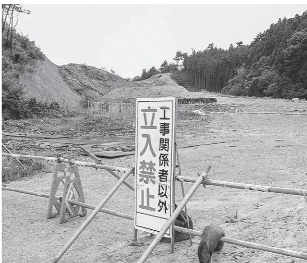
防災対策工事中の現場
