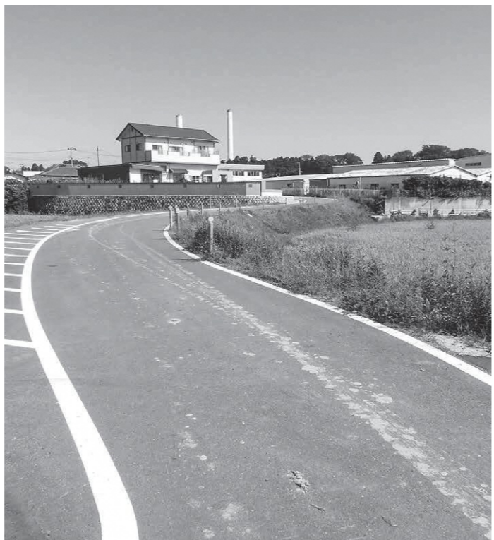
舗装された松葉線(下北迫)
