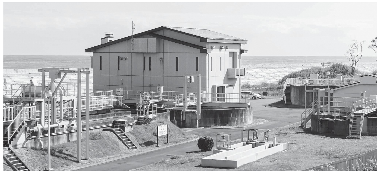
広島市浄化センター
