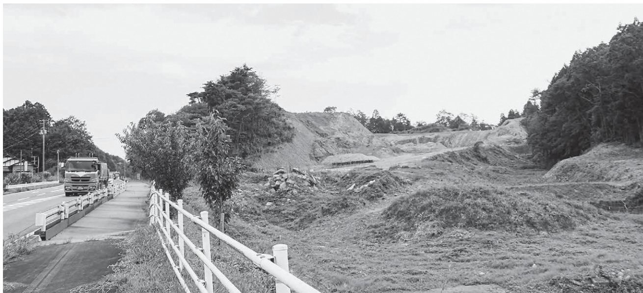
事業が休止している道の駅建設現場
