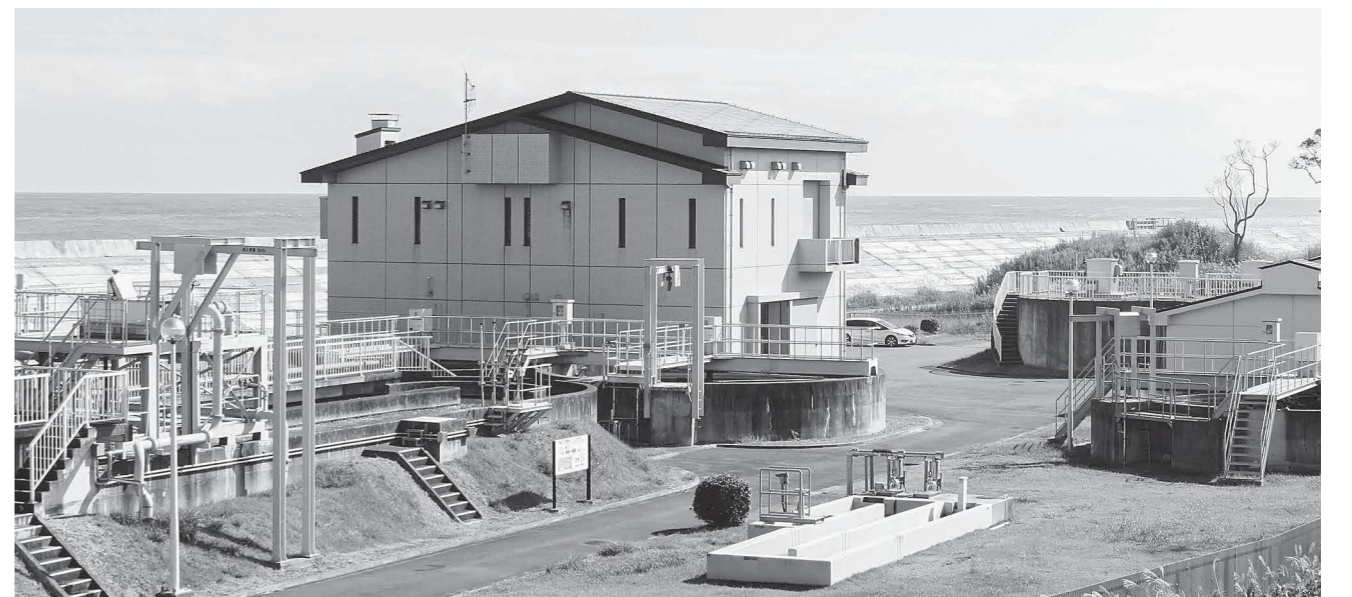
広野町浄化センター
