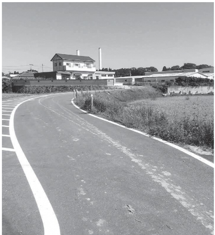
舗装された松葉線(下北迫)
