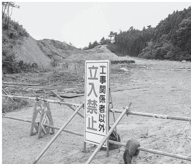
防災対策工事中の現場
