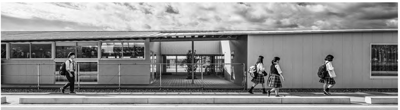
北東側のデッキを北側の道路から見る
