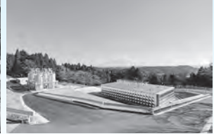
配水池・ろ過機
