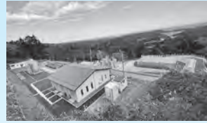
小滝平浄水場全景
