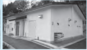
浄水場管理棟
