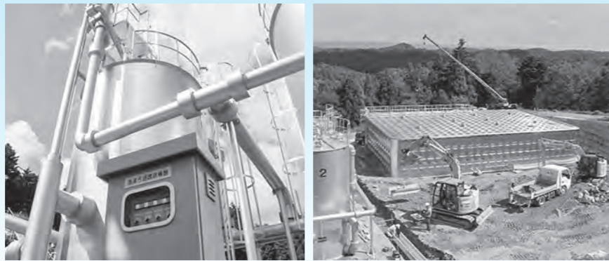
整備された現場盤とNo.1ろ過機
