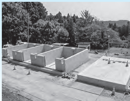
躯体築造が完了した天日乾燥床
