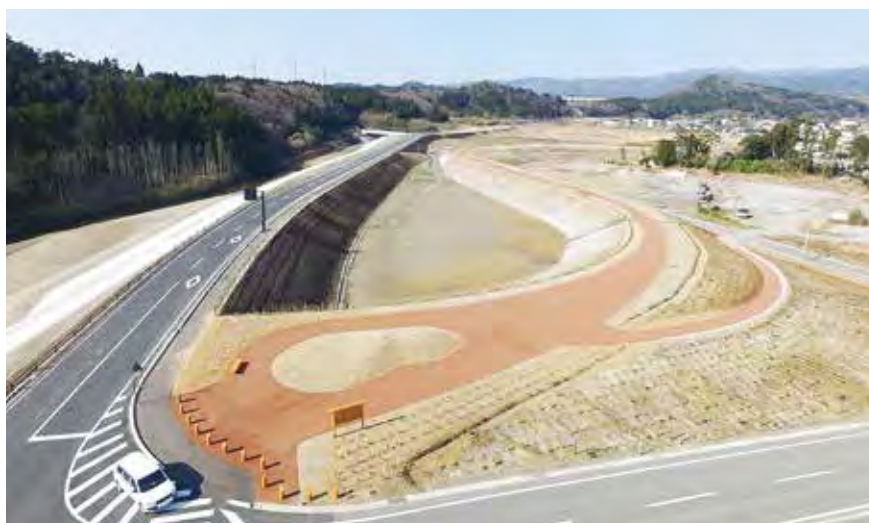
防潮堤、県道広野小高線と防災緑地により津波災害を多重防御
