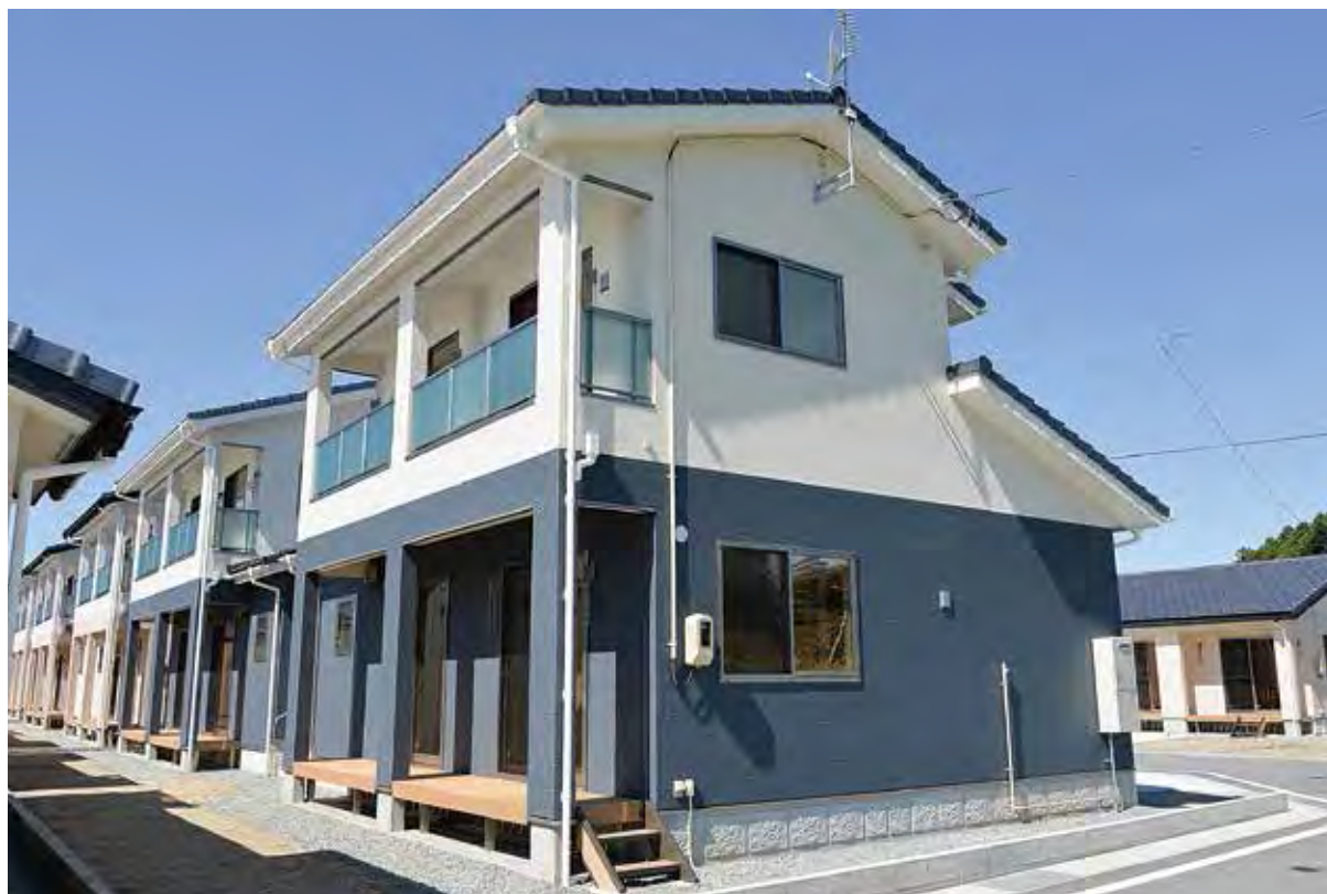
下北迫地区に整備された復興公営住宅県営下北迫団地
