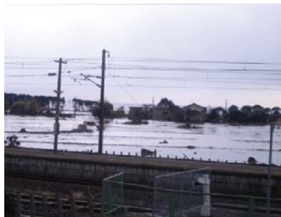
広野駅の線路を境に東側は津波により浸水（3月11日）
