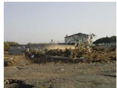
津波の被害を受けた下水処理場（3月13日）
