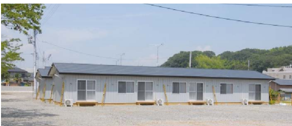
8月18日から入居開始した常磐迎応急仮設住宅
