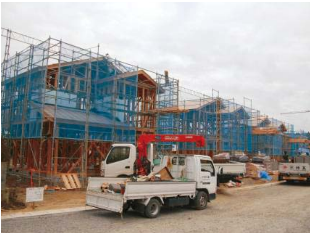
集合住宅38戸、戸 建て住宅10戸の災 害公営住宅 (平成25年9月26日 起工)
