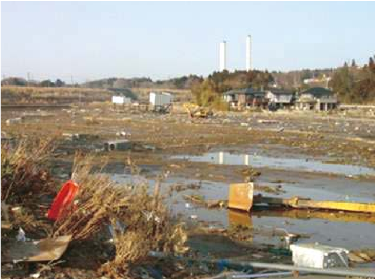
津波被害にあった北釜地区
